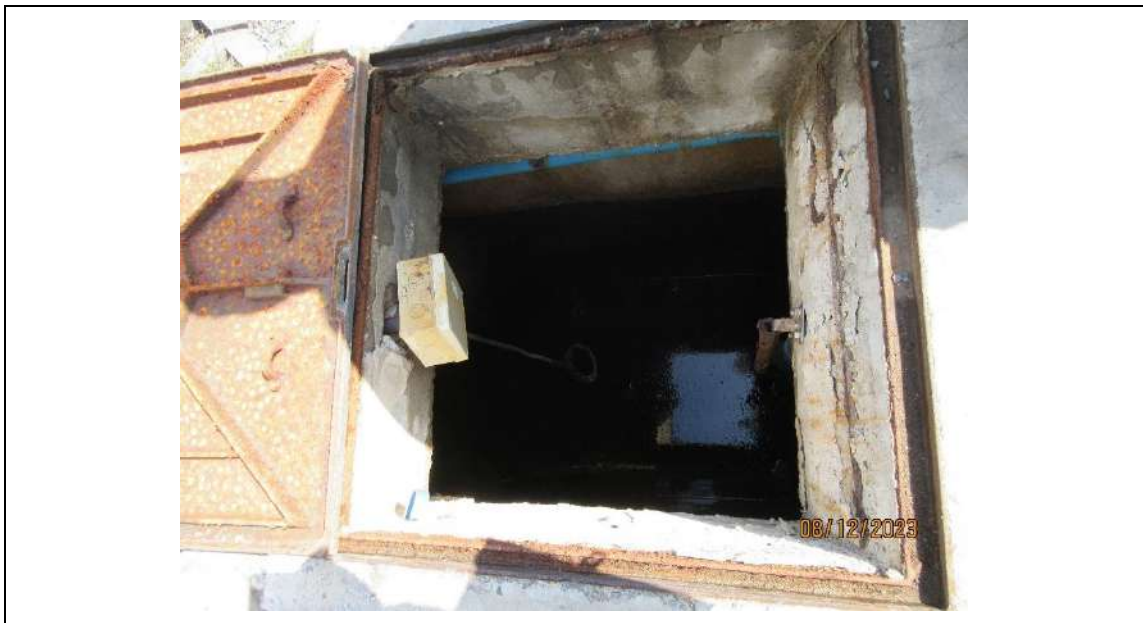
รูปที่ 3-3 ภาพถ่ายสภาพบ่อเติมอากาศของระบบบำบัดน้ำเสียรวม
